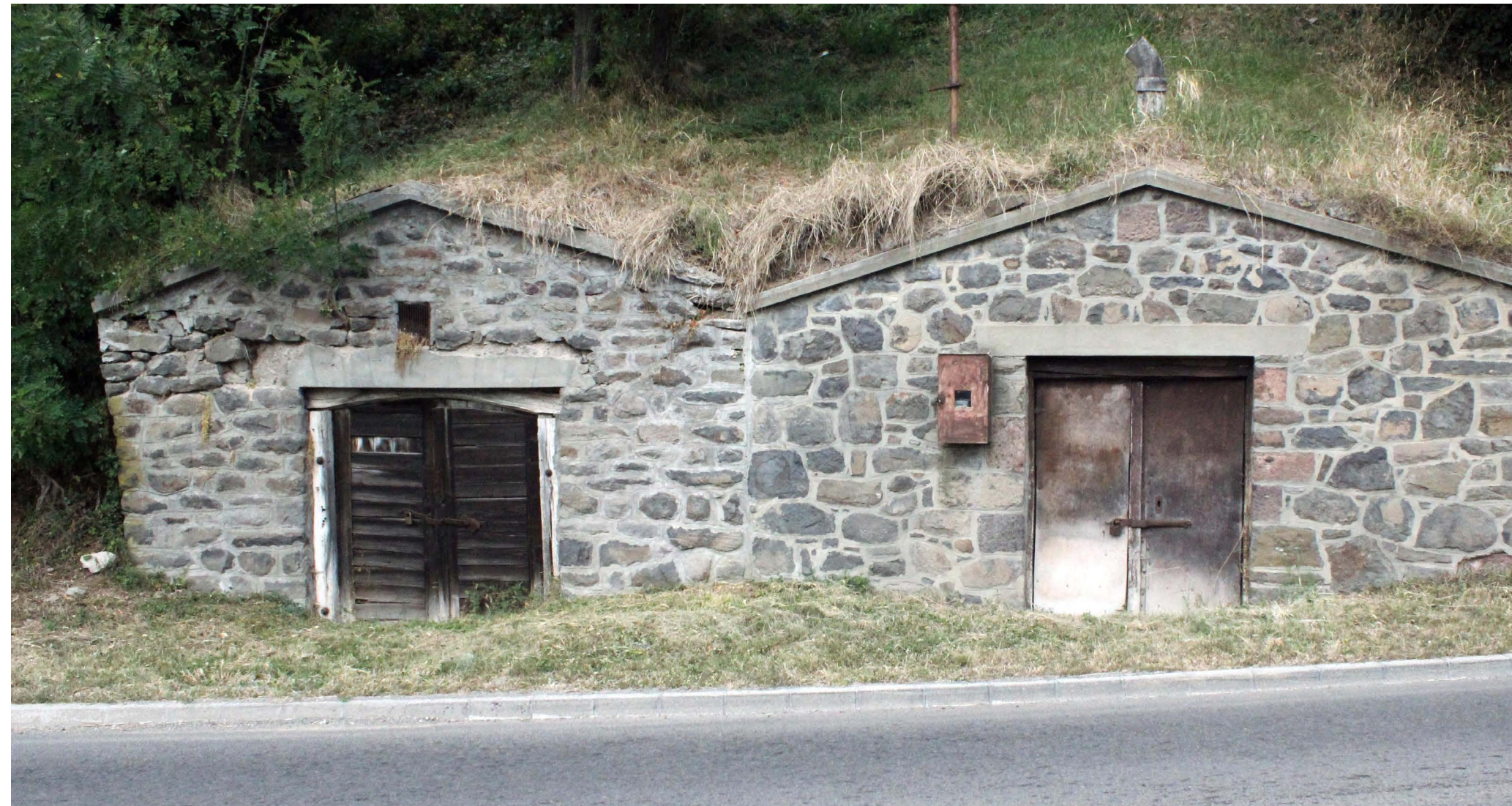
Örökségünk - Épített emlékek Pincesor
