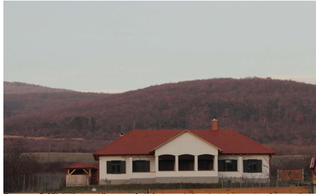
Egyszerű földszintes tömeg, fehér homlokzat. A hagyományos tornác korszerű újragondolása. Hagyományos tetőforma és tetőfedő anyag.
