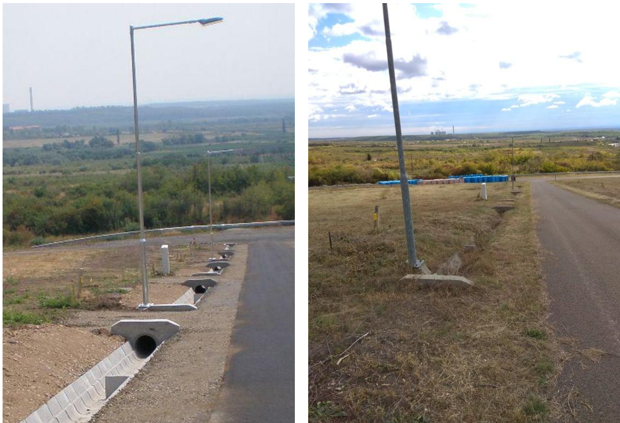
Beépítési terület csapadékvíz-elvezetése az átadás után 2013-ban és 2019. októberében
