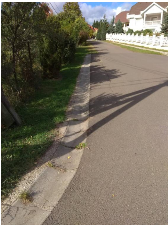
Burkolt árok energiatörő fogakkal
